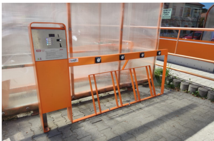
Chlum u Třeboně jednota COOP 4x230 V, stojan s mincovníkem pro nabíjení elektrokol
